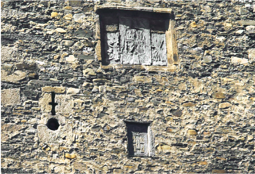
FIG. 1 Escudo de los Reyes Católicos, de su alcaide y troneras de artillería en una torre del castillo de Ponferrada construida tras su toma por la Corona. Foto Fernando Cobos.
